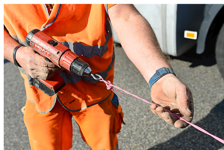
Die Drähte müssen zusammengedreht werden, damit zwischen der Schleife und dem Auswerter kein Magnetfeld entsteht.
