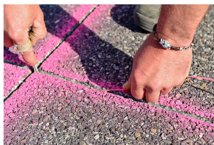
Von Hand und millimetergenau verlegt Urs Hadorn die Drähte, welche das Induktionsfeld bilden.
