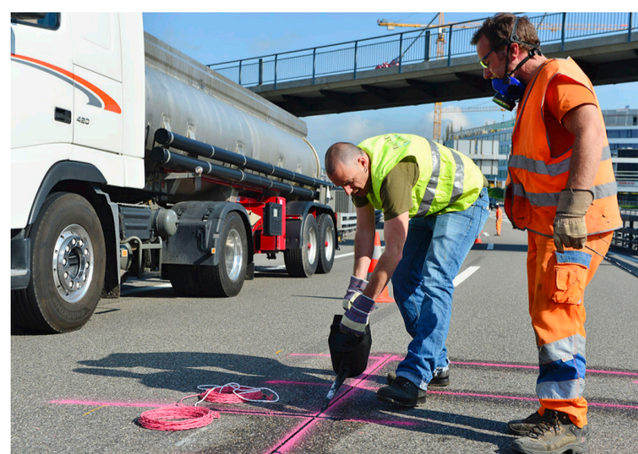
Niklaus Bigler begutachtet kritisch, wie TT-Redaktor Marco Zysset das heisse Bitumen in die Schlitz eingiesst.
